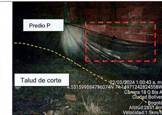
Fotografía 6. Talud de corte realizado para el emplazamiento de la vivienda.
