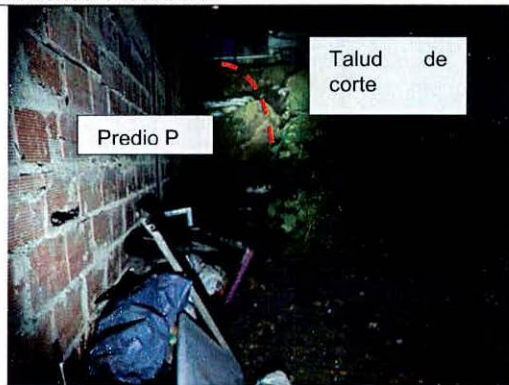
Fotografía 5. Talud de corte realizado para el emplazamiento de la vivienda.
