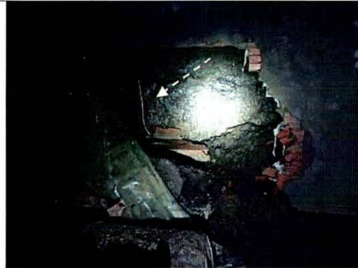
Fotografía 3. Muro del costado posterior de la vivienda evaluada.
