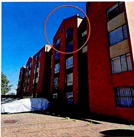
Fotografía No. 1. Vista general del exterior 5.
