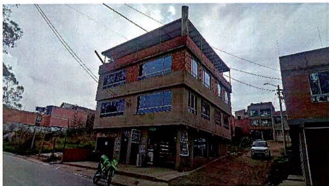
Fotografía No. 1. Vista general de la edificación
