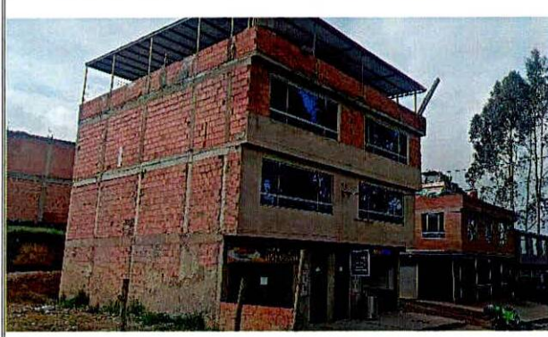
Fotografía No. 2. Vista lateral de la edificación
