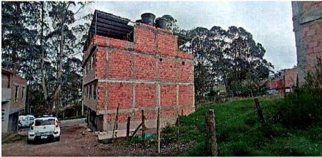
Fotografía No. 3. Vista posterior de la edificación.
