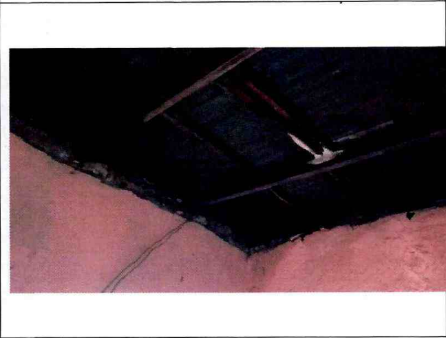
Fotografía 8. Elementos de madera que soportan la cubierta en zona de cocina, costado oriental de la edificación evaluada
