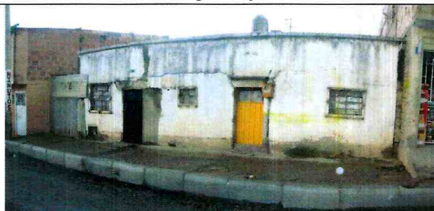
Fotografía 3. Fachada de la edificación evaluada DI-4818 (2010)
