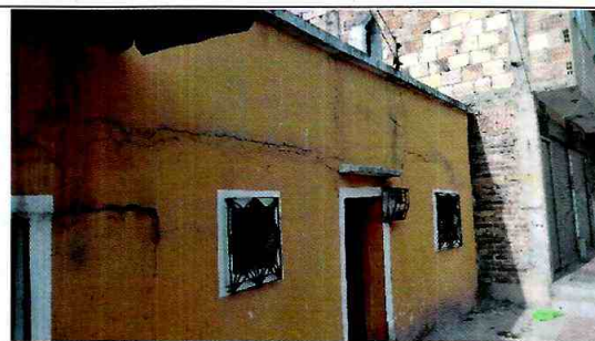
Fotografía 1 y 2. Muestra de fisuras identificadas en fachada de la edificación evaluada
