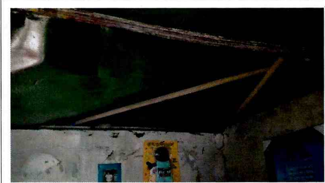
Fotografía 9. Cielo raso y elementos de rigidez existentes en la zona central de la edificación evaluada
