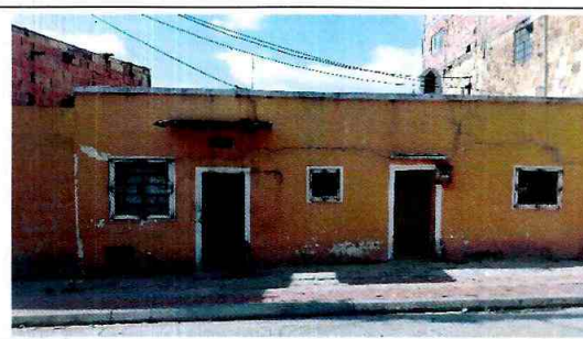
Fotografía 4. Fachada de la edificación evaluada. DI-14508 (2020)
