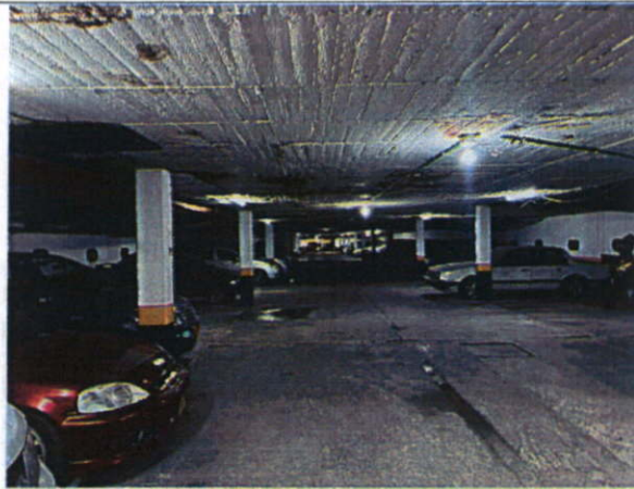
Fotografía 4. Vista general de la plataforma de parqueaderos
