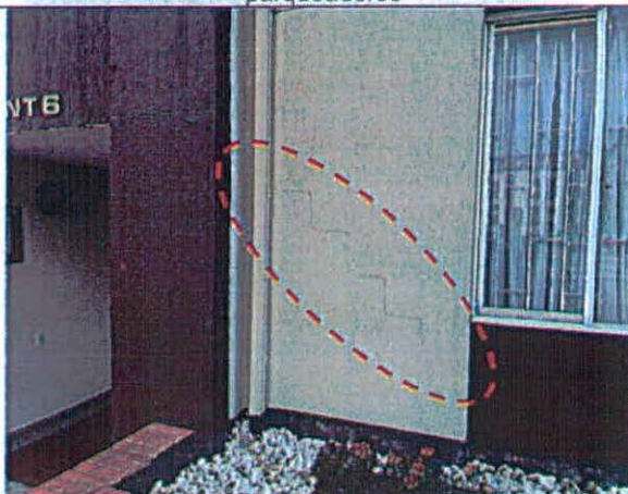
Fotografía 6. Fisuras y grietas de tendencia escalonada en muros perimetrales de las edificaciones del predio
