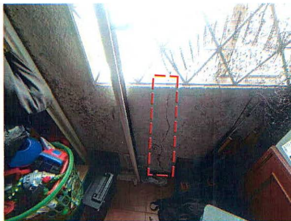
Fotografía 14. Grieta sobre antepecho de ventana posterior del piso 2 de P2. Tomado el 24/04/2024
