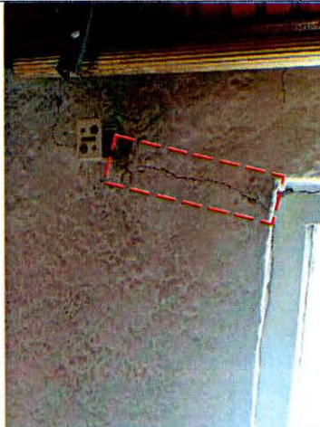
Fotografía 9. Grieta en esquina de muro de piso 2 del P1. Tomada del DI-16338 (21/09/2021)
