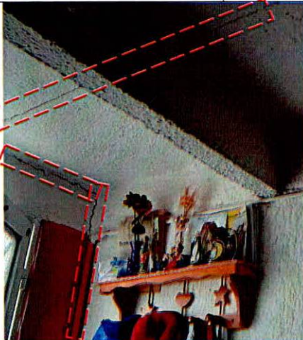
Fotografía 9. Grieta en esquina de muro de piso 2 del P1. Tomada del DI-16338 (21/09/2021)
