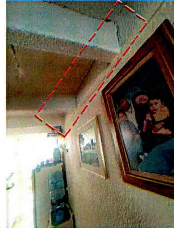
Fotografía 8. Fisura sobre intersección muro-entrepiso en P1. Tomada el 24/04/2024
