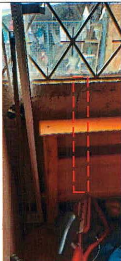
Fotografía 13. Grieta sobre antepecho de ventana posterior del P2. Tomada del DI-16338 (21/09/2021)
