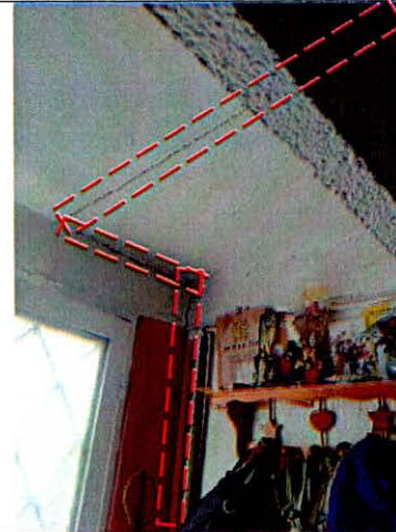
Fotografía 10. Grieta en esquina de muro de piso 2 del P1. Tomada el 24/04/2024
