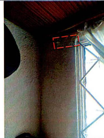
Fotografía 10. Grieta en esquina de muro de piso 2 del P1. Tomada el 24/04/2024
