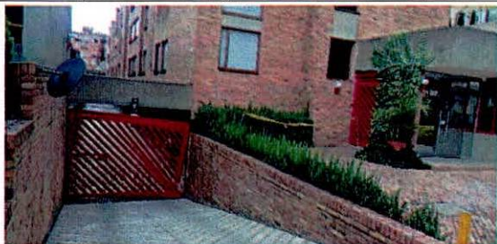
Fotografía 3. Vista general del portón metálico costado sur
