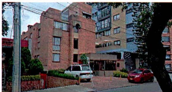
Fotografía 1. Vista general del edificio costado sur.
