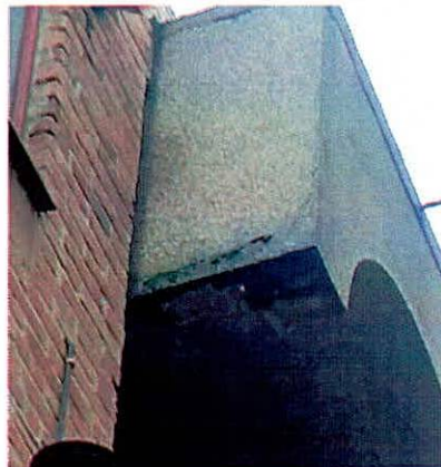
Fotografía 8. Vista general de humedad en las pérgolas
