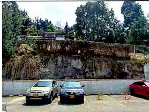
Fotografía 9. Talud de corte del costado oriental del predio P1, zona de estacionamiento descubierto (27 de febrero de 2024).
