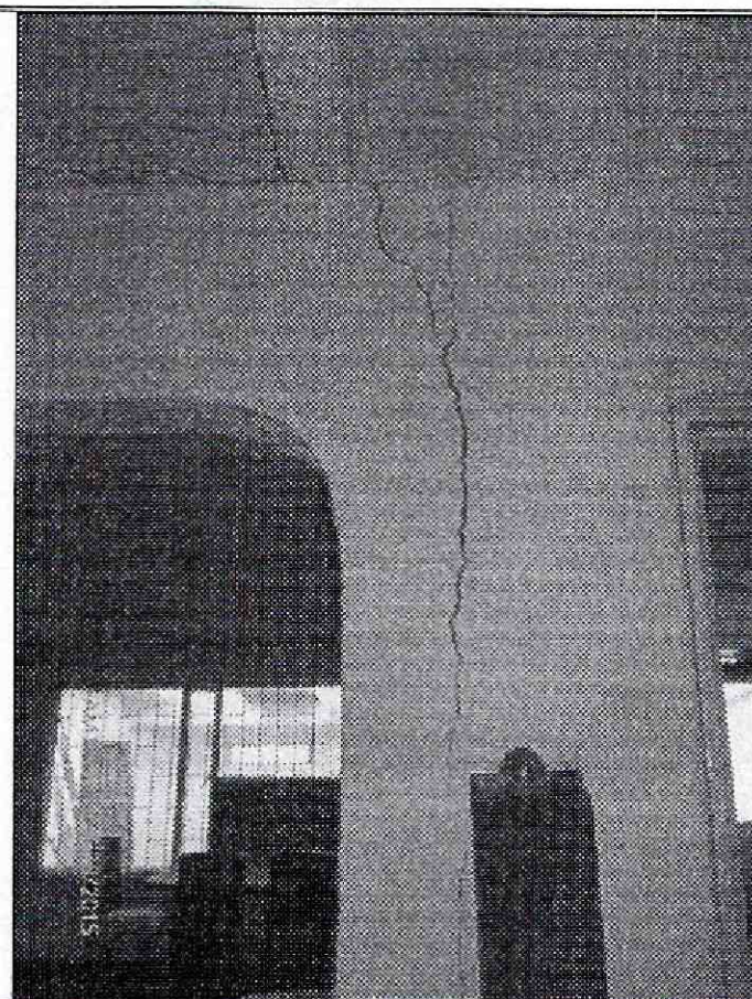
Fotografía 26. Grietas identificadas en muros de la estructura principal de la vivienda de la Carrera 57 No. 170 A – 04, en el Sector Catastral Villa del Prado de la Localidad Suba, la cual por los severos daños fue recomendada a evacuar.
