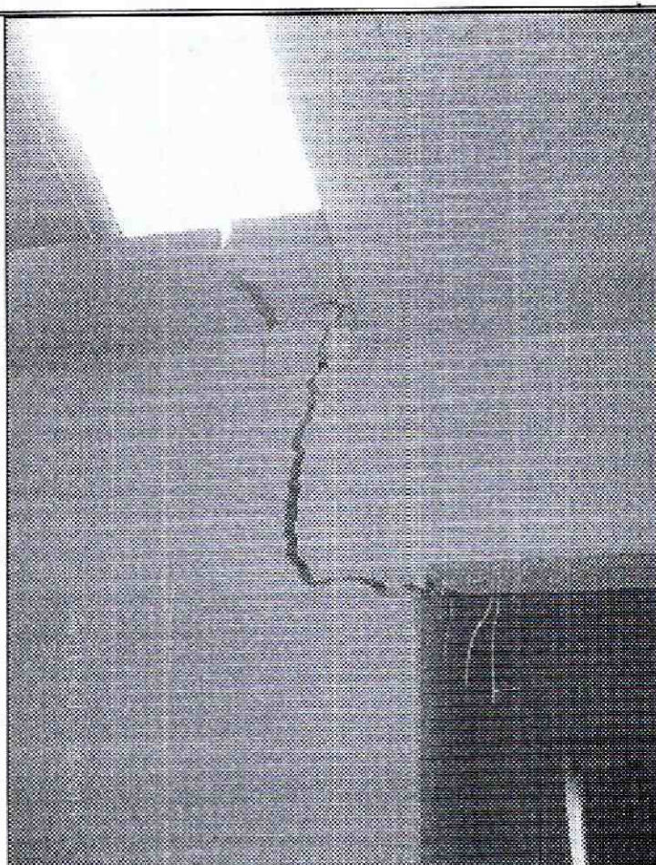
Fotografía 29. Grietas identificadas en muros de la estructura principal de la vivienda de la Carrera 57 No. 170 A – 04, en el Sector Catastral Villa del Prado de la Localidad Suba, la cual por los severos daños fue recomendada a evacuar.
