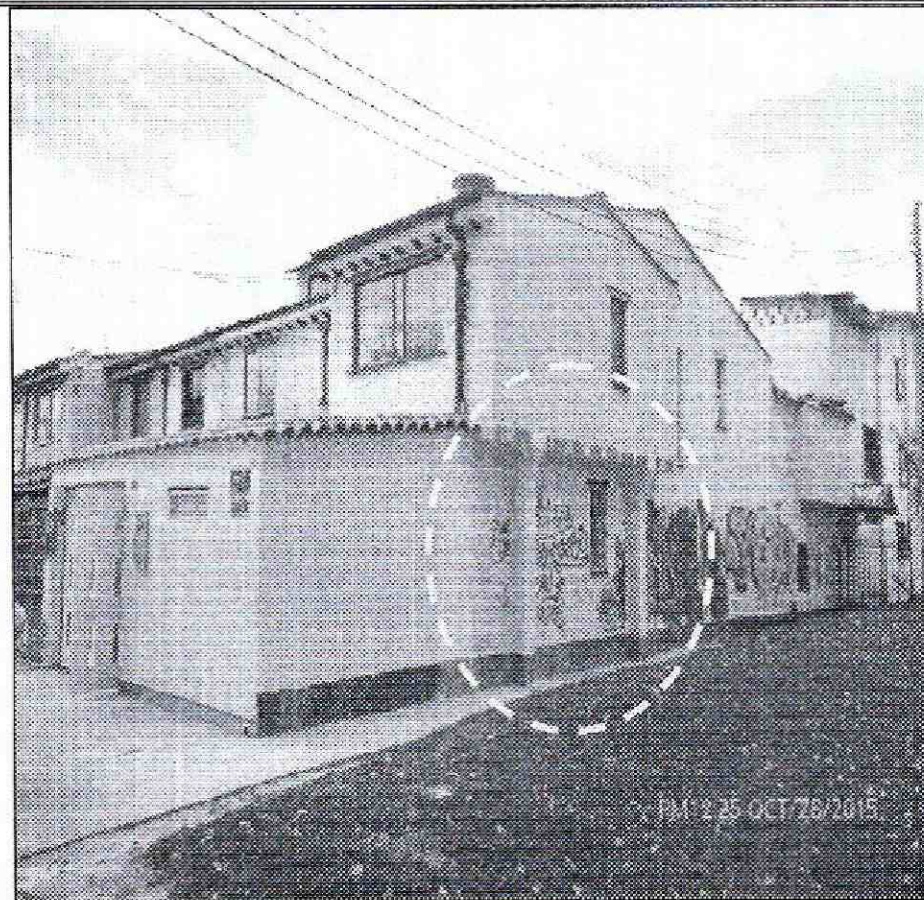
Fotografía 32. Columnas construidas al costado sur de la vivienda de la Carrera 57 No. 170 A – 04, en el Sector Catastral Villa del Prado de la Localidad Suba, con el propósito de impedir el avance de los daños.
