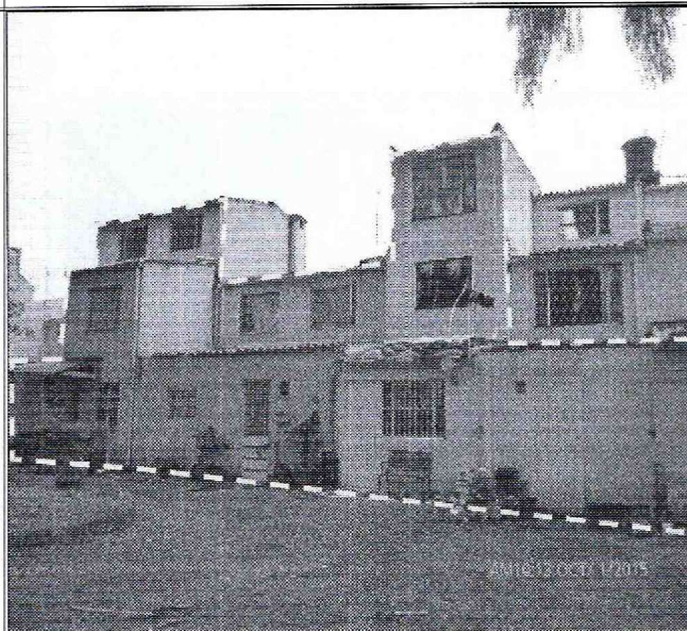
Fotografía 5. Ampliaciones en planta y en altura, desarrolladas en viviendas del polígono evaluado en la Carrera 56 y la Carrera 62, entre la Calle 170 y la Calle 172 A, en el Sector Catastral Villa del Prado de la Localidad Usaquén.
