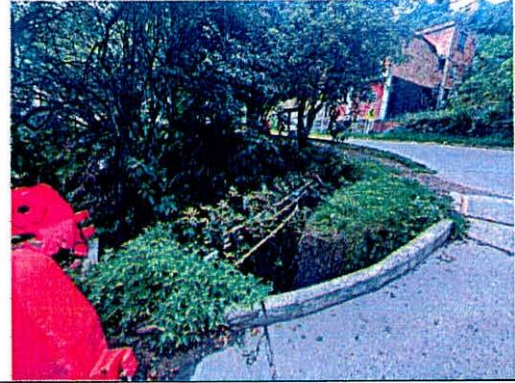
Fotografías 15 y 16. Desprendimientos de material de suelo Quebrada Puente Piedra (Fotografía tomada el 12 de junio de 2024)
