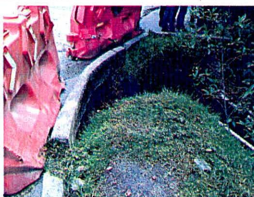
Fotografías 5 y 6. Desprendimientos de material de suelo Quebrada Puente Piedra (Fotografía tomada del diagnóstico técnico DI-19057)
