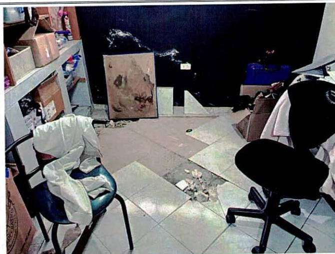
Fotos 3 y 4. Daños identificados en piso del semisótano
