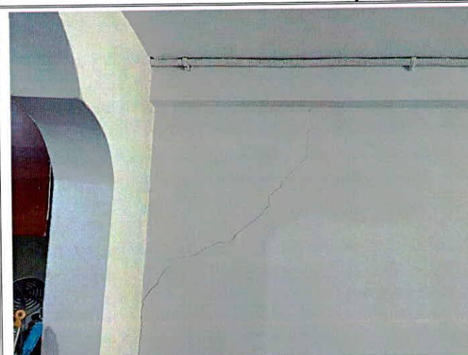
Fotos 5 y 6. Daños identificados en paredes del semisótano
