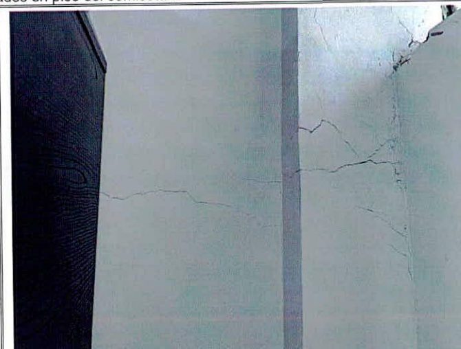
Fotos 5 y 6. Daños identificados en paredes del semisótano
