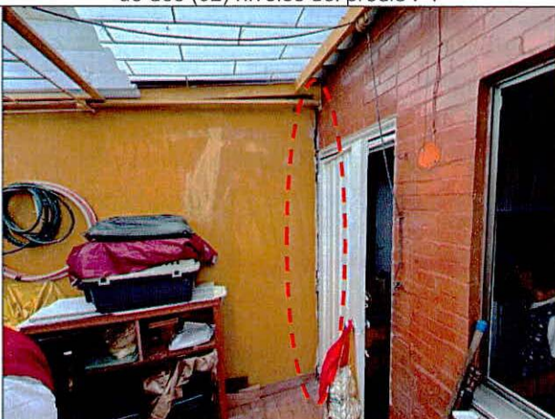
Fotografía 8. Separación entre muro del patio y la vivienda de dos (02) niveles del predio P2
