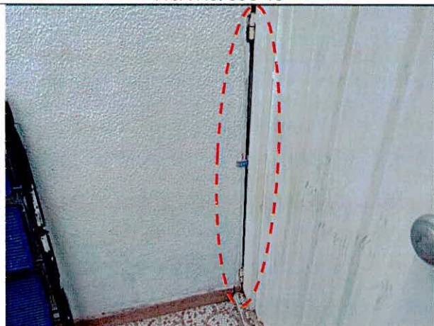
Fotografía 7. Separación entre muro del patio y la vivienda de dos (02) niveles del predio P1
