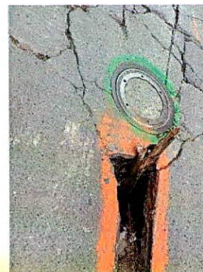
Fotografías 7 y 8. Pozo de inspección de la red de alcantarillado colapsado entre la Carrera 11 Este No.96A-38 a la Carrera 11 Este No. 96C-18.
