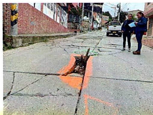
Fotografías 7 y 8. Pozo de inspección de la red de alcantarillado colapsado entre la Carrera 11 Este No.96A-38 a la Carrera 11 Este No. 96C-18.
