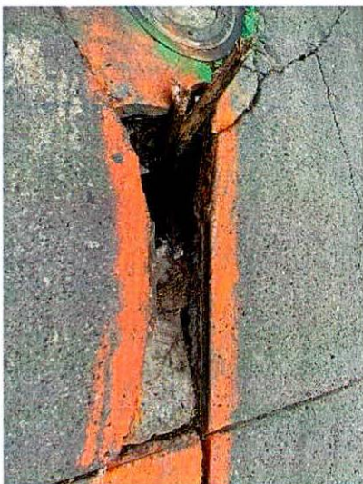
Fotografías 9 y 10. Pozo de inspección de la red de alcantarillado colapsado entre la Carrera 11 Este No.96A-38 a la Carrera 11 Este No. 96C-18.
