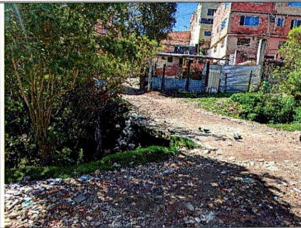
Fotografía No. 2. Vista general del box culvert en el polígono P1.
