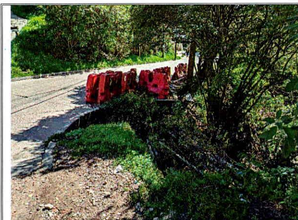
Fotografía No. 5. Vista de tramo vial evaluado en P2.
